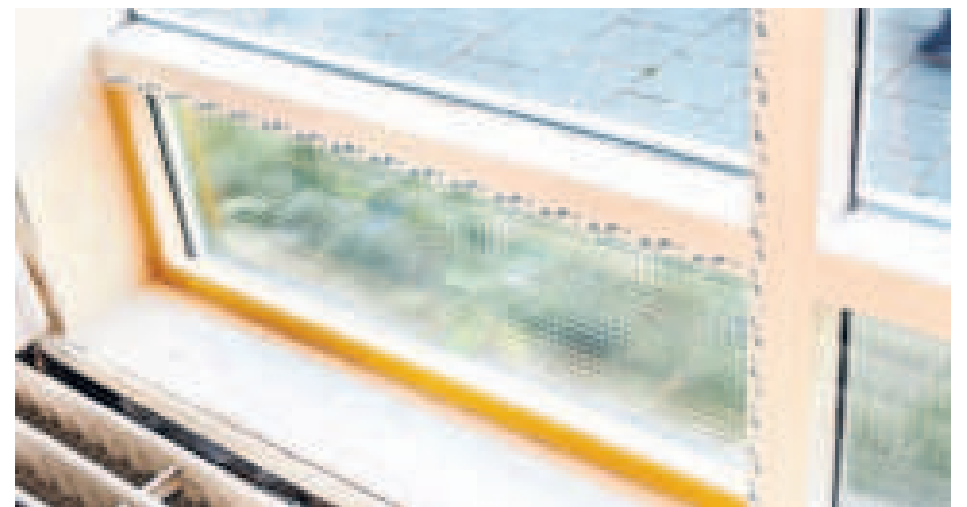
Zelfgemaakt isolatiekozijn. De Fixbrigade (boven) helpt Amsterdammers met weinig middelen met klussen en isoleren. FOTO'S ERIK CARTON, STUDIO OOSTRUM
