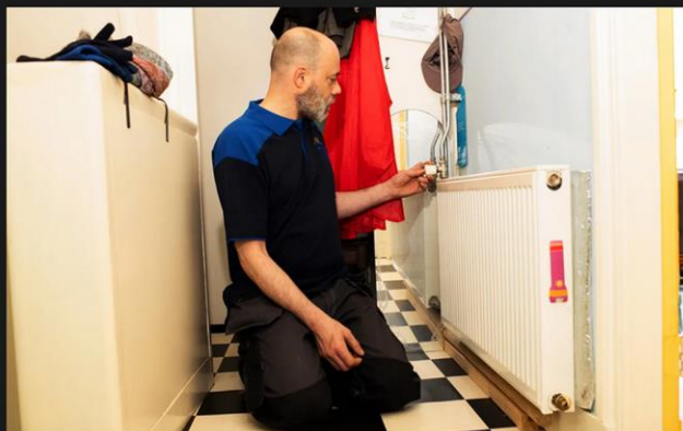
Met enkele kleine ingrepen kan al veel energie worden bespaard, zoals het goed afstellen van de CV en het plaatsen van tochtstrips en radiotorfolie. De FIXbrigade verzorgt dit gratis bij mensen thuis die het niet al te breed hebben. Foto Niels Blekemolen
